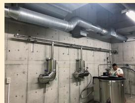
液体窒素タンクの温度確認作業中
